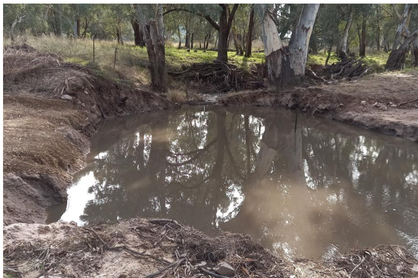
Photo : Adelargo Road Culvert Site
