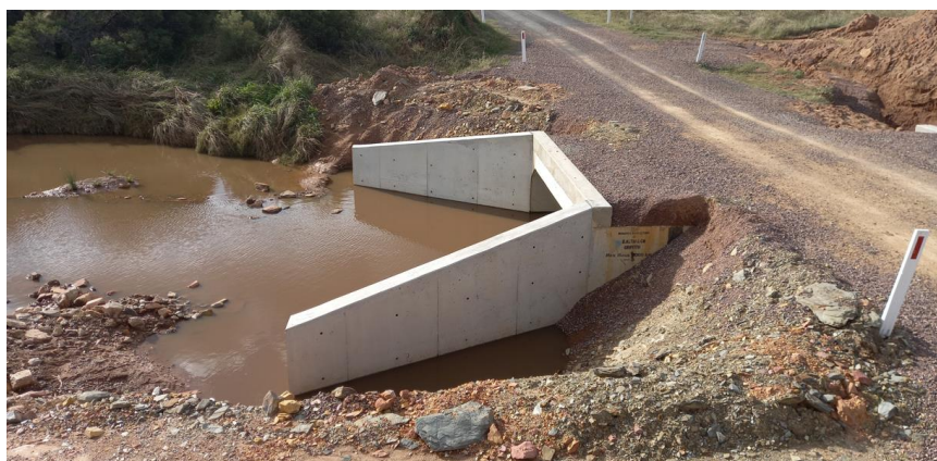
Photo : Hancock-Flinns Road - Culvert Site
